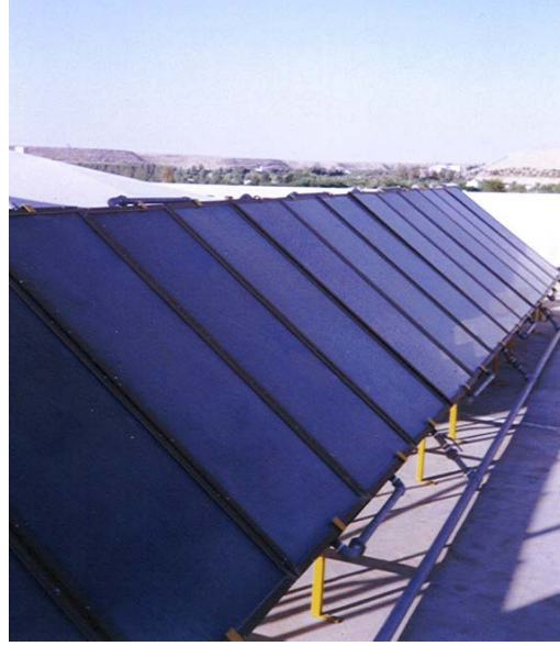
شكل (٤) صورة المجمع الشمسي المستخدم للتسخين ، مع توضيح ارتباط التسخين مع دورة الماء في جهاز التنقية
